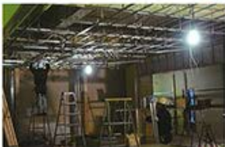
11月26日 電気工事
