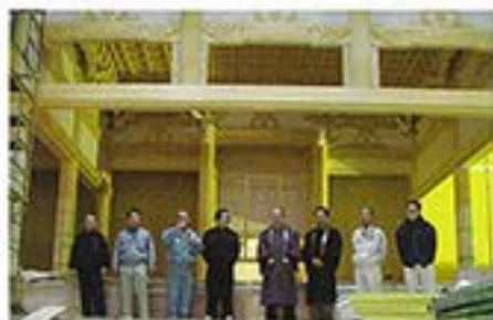
2月1日 内陣宮大工工事終了
