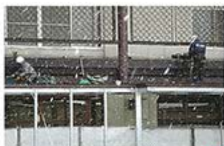
12月22日 吹雪の中での屋外 通路工事
