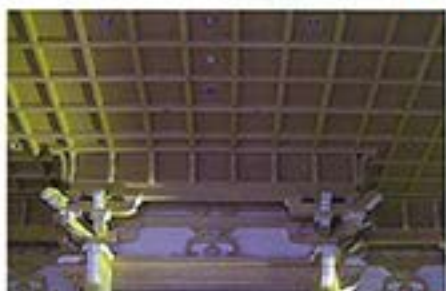
2月1日 本堂内陣の天井
