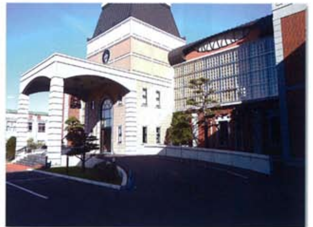
玄関前スロープ
