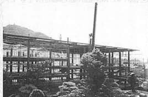
庫裡復興工事
